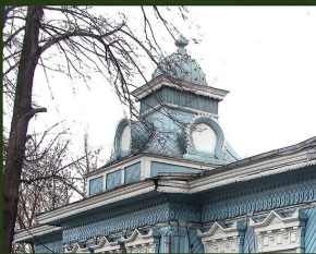
Дом священника Знаменской церкви. Ориентировка: Фасад. Томск, ул. Сибирская, 1. Фото: 2021 г. И.А. Тихомирова Анастасия Мещеряковичева, 1902 г. Алексей Яковлевич Мещеряков, 1902 г.
