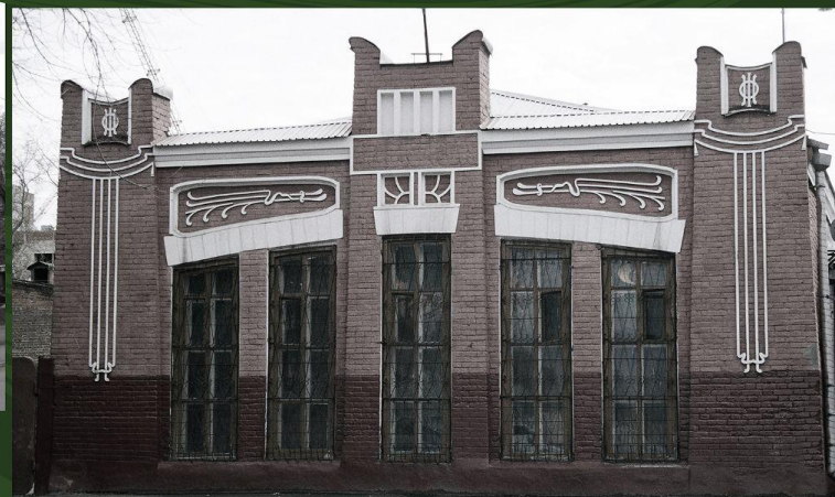
Литейная мастерская при ремесленном училище А.И. Текутьева. Построена в 1914 г. Тюмень, ул. Осипенко, 2 (до 1937 г. – ул. Томская, до 1939 г. – ул. Н.И. Ежова). Архитектор К.П. Чакин Фото В.А. Чулина, 2002 г.
