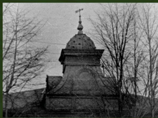
Дом священника Знаменской церкви. Построен в 1906 году. Ориентировка: Пискарев, ул. Сибирская, 1. Фото: 2021 г. И.А. Тихомирова Анастасия Мещеряковичева, 1902 г. Алексей Яковлевич Мещеряков, 1902 г.
