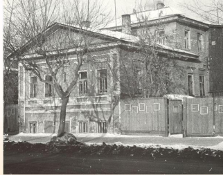
Музыкальная школа с мечетью открыта в 1905 году в доме на ул. Славской, 9 (ул. Ленина, 13), реконструирована для театральных постановок. Сфотографирован в 2008 г. от дома А. Чичина 2002 г.
