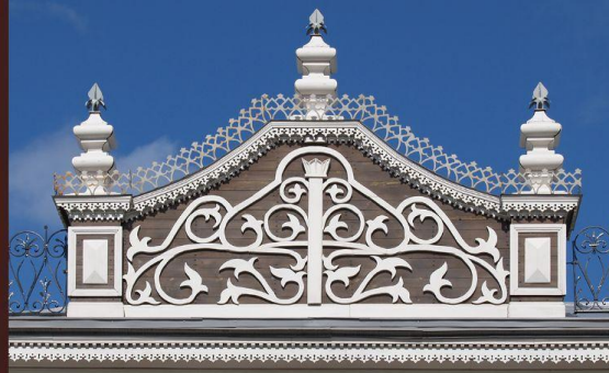
Дом В.С. и К.В. Половых. Фрагмент Аттика после реставрации 2000-х гг. Тюмень, ул. Володарского, 7 Фото В.А. Чулина, 2008 г.
