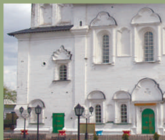
Западный фасад Троицкого собора. Слева - двухэтажный северный придел с «пламенеющими» очельями окон. Справа - основной объём собора (Троицкая церковь) с трёхлепестковыми и полуциркульными очельями окон. Фото А.А. Ермаков. 2007 г.
