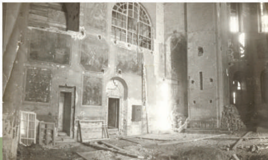
Интерьер Троицкого собора. Северная стена с росписью. 1984 г. Фото А.С. Чепуриного(?) Инспекция по охране и использованию памятников истории и культуры г. Тюмени
