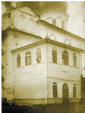
Деревянная паперть у западного фасада Троицкого собора, с лестницей на второй этаж, в придел Преображения Господня. Построена игуменом Филаретом в конце 1880-х – начале 1890-х гг. Автор фото не установлен ФГБУК «Государственный научно-исследовательский музей архитектуры имени А.В. Щусева» (г. Москва)
