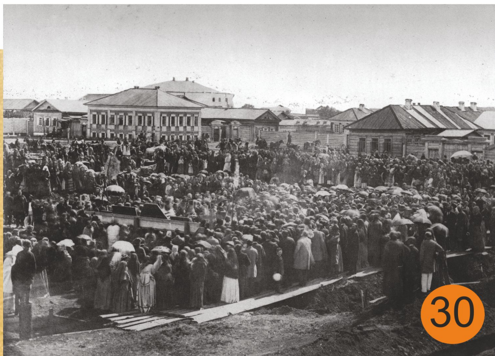
Закладка здания реального училища в Тюмени. 31 мая 1877 г. Фотограф Н.А.Терехов. Двухэтажный дом слева – памятник истории и культуры по ул. Тургенева, 9
